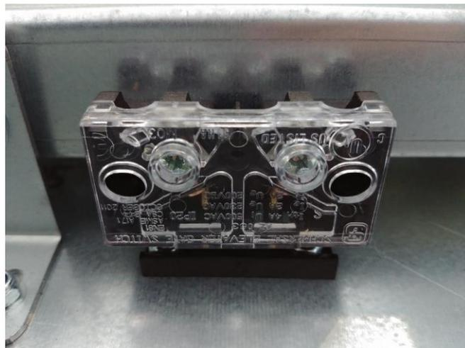
Der Installateur muss den Schalter an die Sicherheitsvorgänge der Bewegung anschließen, so dass der Aufzug in normalen Betrieb mit verriegelter Schürze und geschlossenem Schalter gesetzt werden kann; und so dass die Schürze nur dann in Bewegung gesetzt werden kann, wenn die restliche Voraussetzungen erfüllt werden, für Wartungsarbeiten, und der Schalter offen ist (gemäß EN801/2, EN81-21 bzw. EN81.20).
